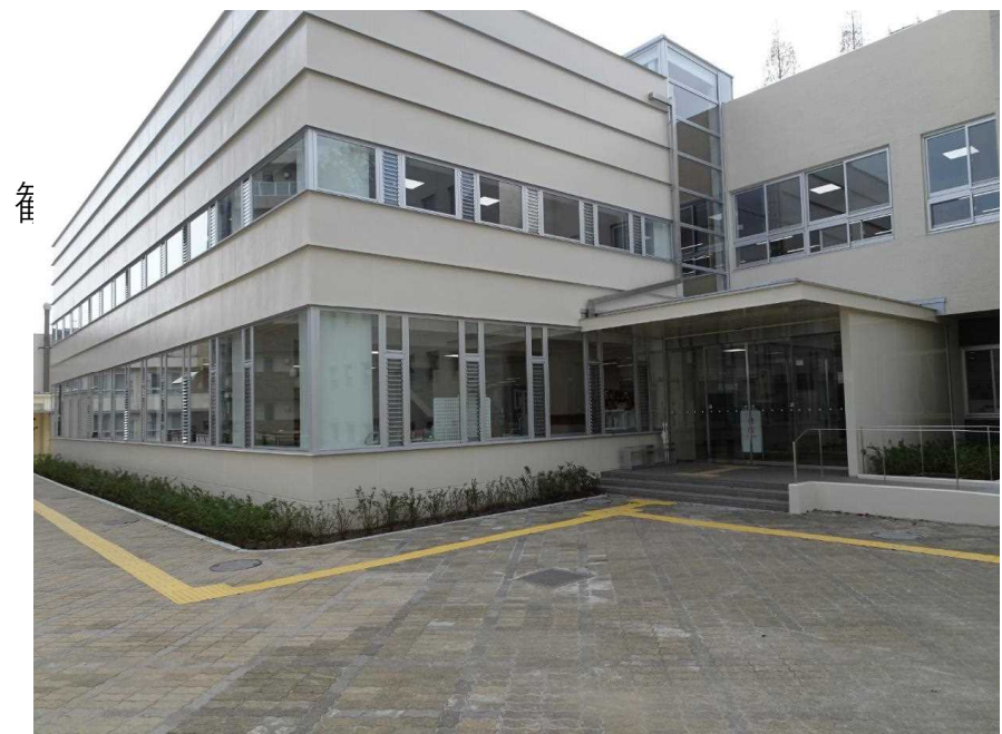
After 北側 2階建 600m 2 の増築 北側エントランス設置
